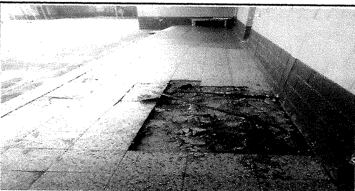
Foto 3: Reparación del piso de aulas 4 y 5 del establecimiento.
