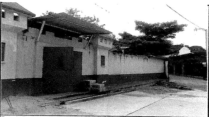
Foto 3: Reparación de muro enfrente de la Escuela, durante el proceso
